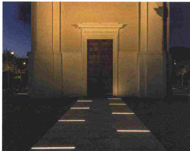
Per il sagrato e i lati della chiesa sono stati scelti apparecchi illuminanti carrabili e modulari da incasso a sviluppo lineare, con corpo in PMMA opalino e diffusore in vetro temperato con lato superiore acidato, dal ridotto consumo energetico (10,5 W e 12 W) e distribuzione luminosa diffusa per tutta la superficie
