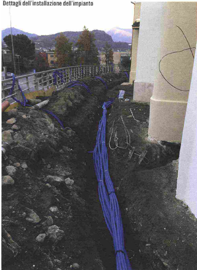
Dettagli dell'installazione dell'impianto
