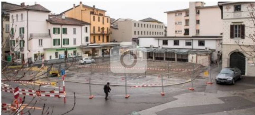
Mendrisio, dopo la demolizione dell'ex Jelmoli (Ti-Press)
